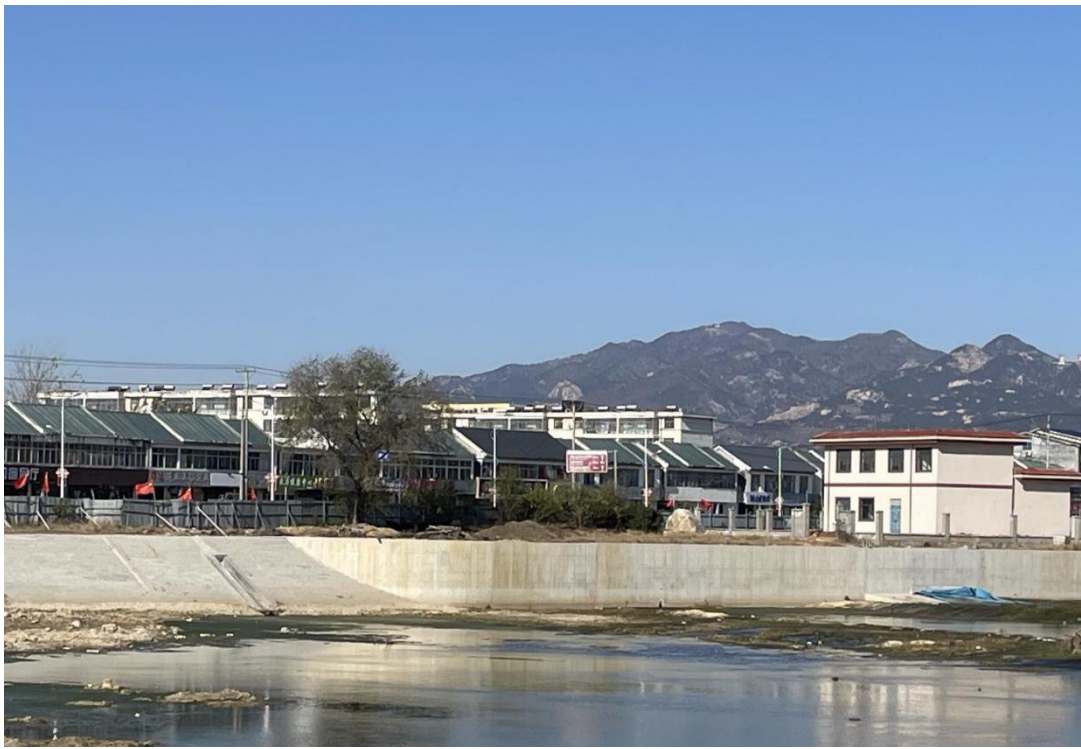
图4-1 薛庄一闸现状照片
