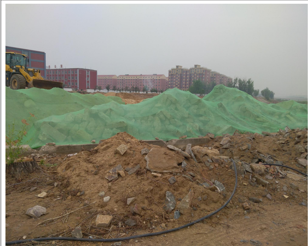
图4-2水土保持措施彩条苫布覆盖
